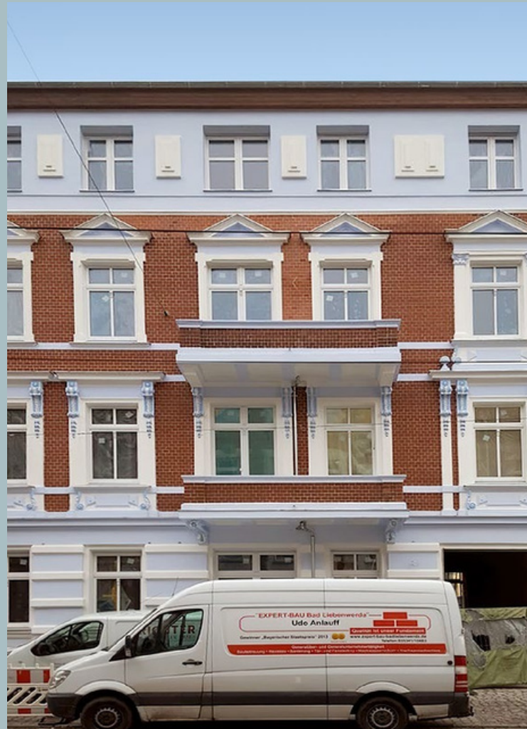
Brandenburg an der Havel, Luckenberger Str. 14 Altbauanierung und Anbau einer Remise, 14 Wohneinheiten Übergabe Objekt April 2020
